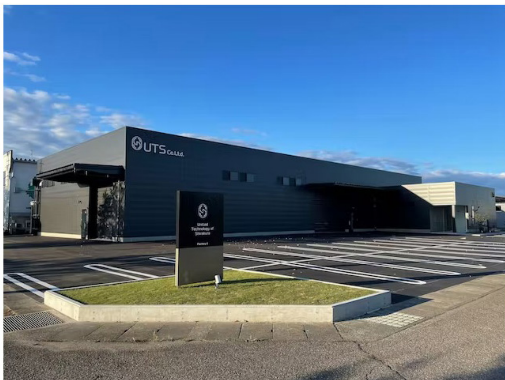
量産品を製造するユーティエスの新工場
